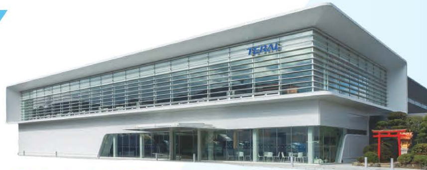
大規模な省エネルギー化を実現したテラル本社社屋
